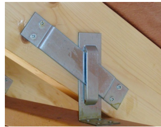
TL型（セtring対応） ログ壁上部取り付け
